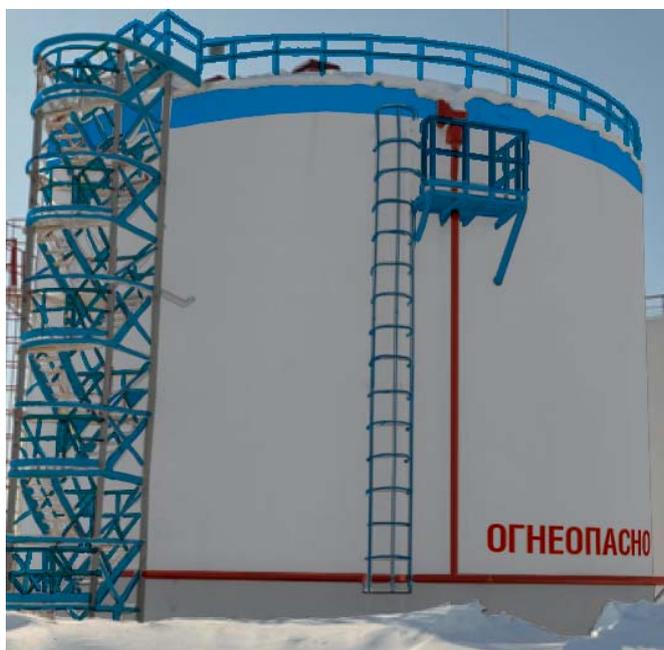
6.3. Резервуар цилиндрический вертикальный
