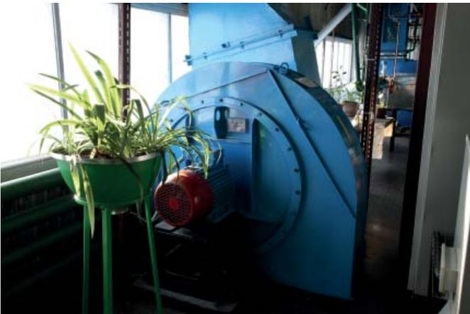
8.2. Привод системы вентиляции
