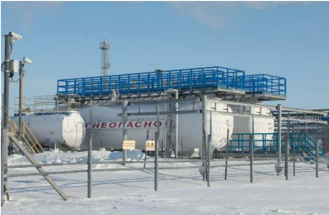
6.2. Резервуар цилиндрический горизонтальный
